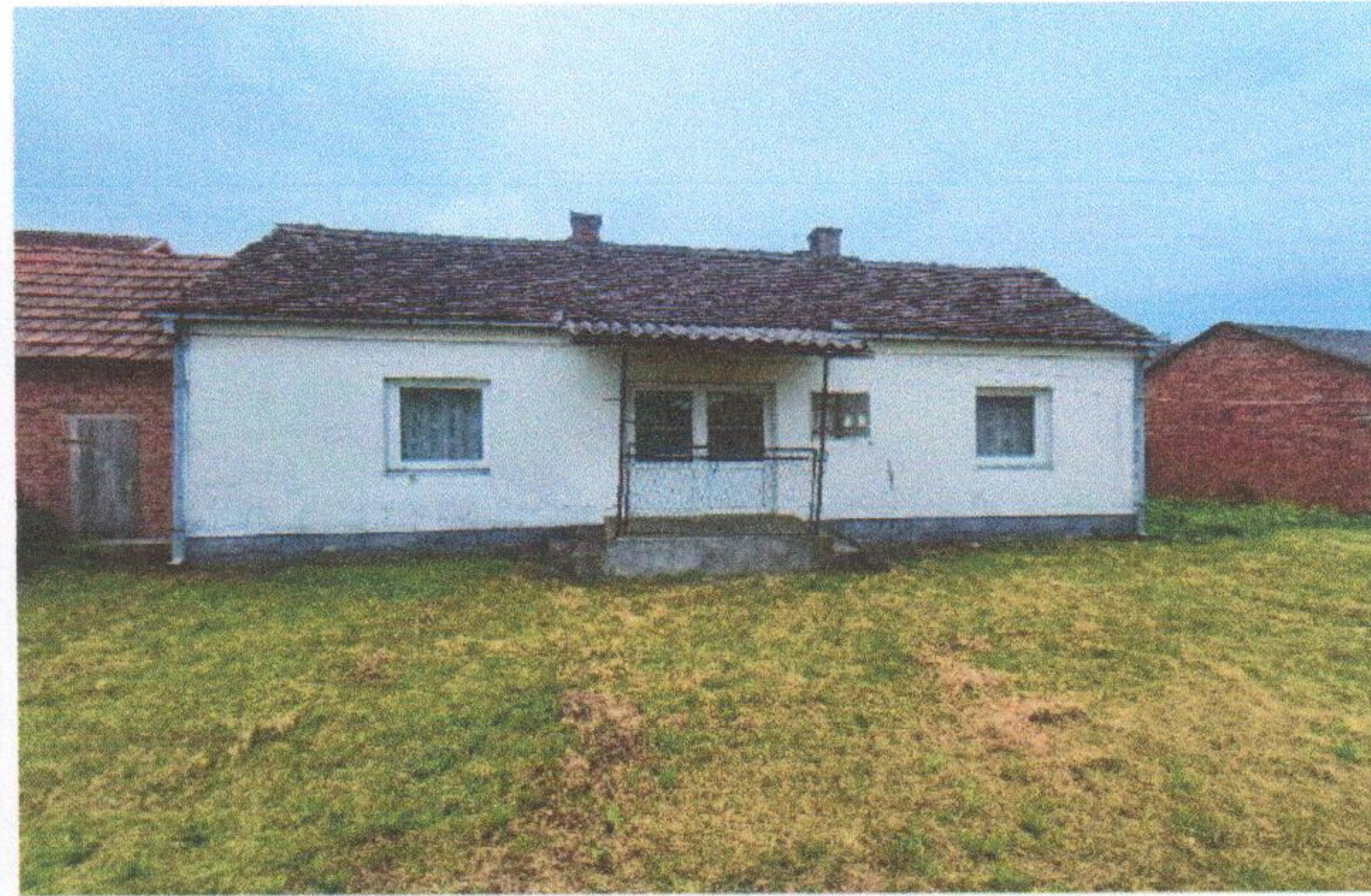
sl.19. Severozapdana dvorišna fasada
