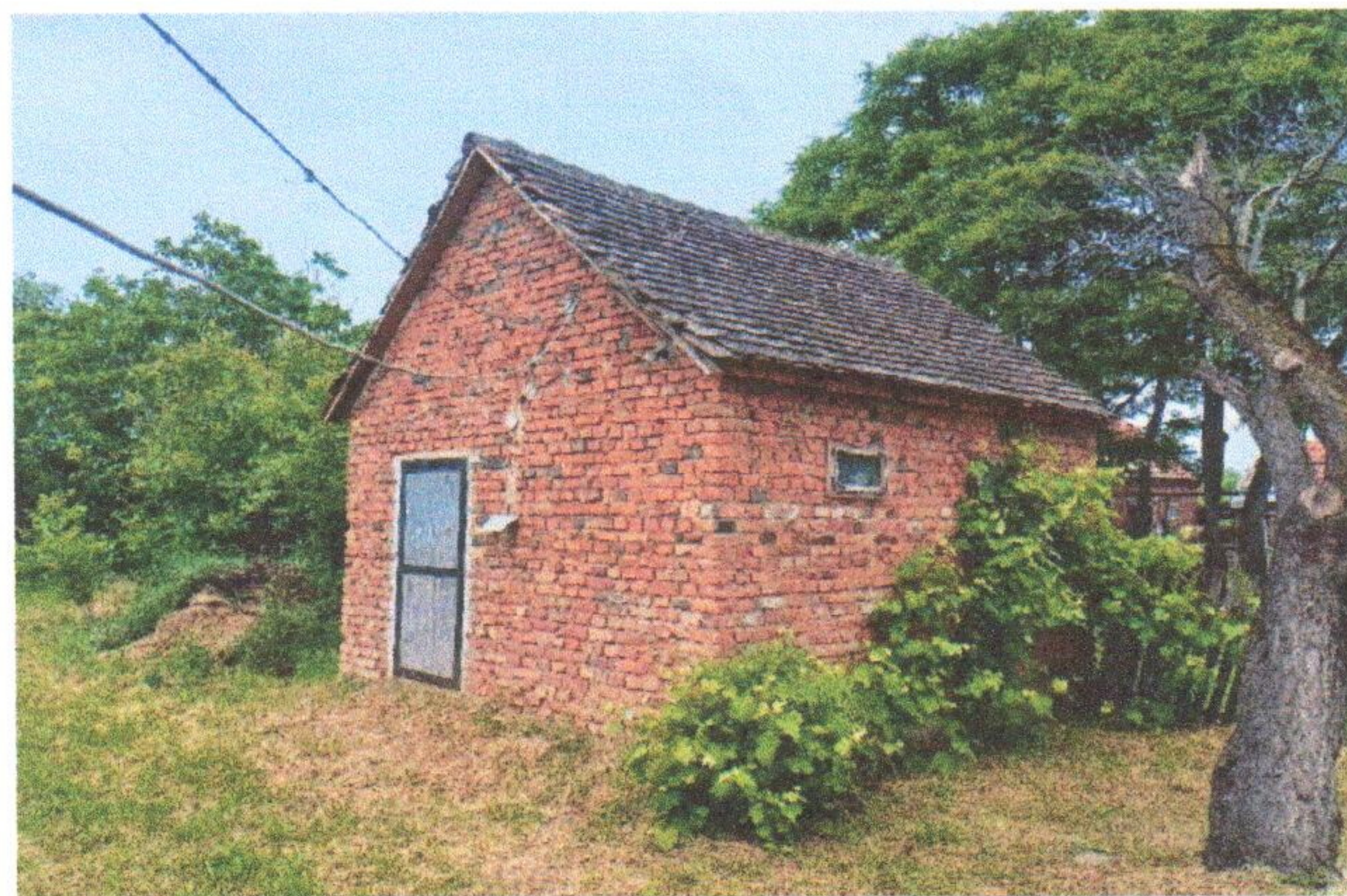
Sl.20. (objekat br.3.) Pomoćna zgrada
