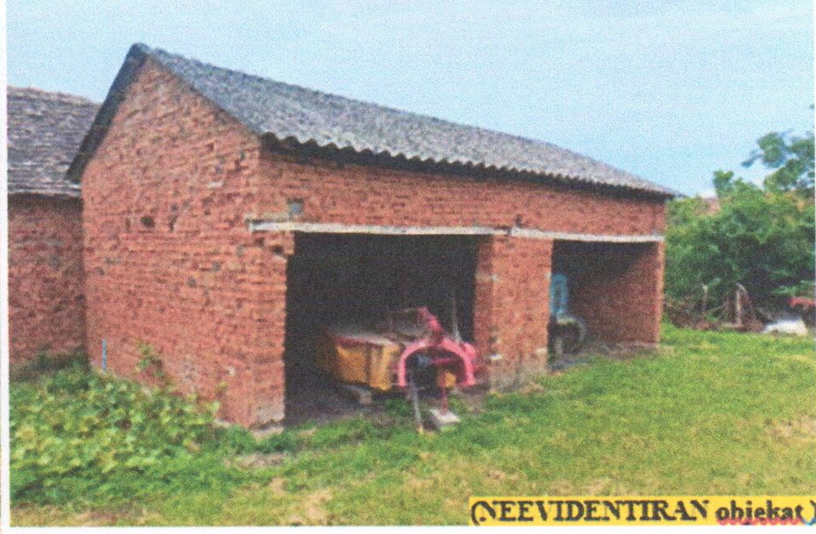
sl.21. Pomoćna zgrada.-ostava poljoprivrednih mašina
