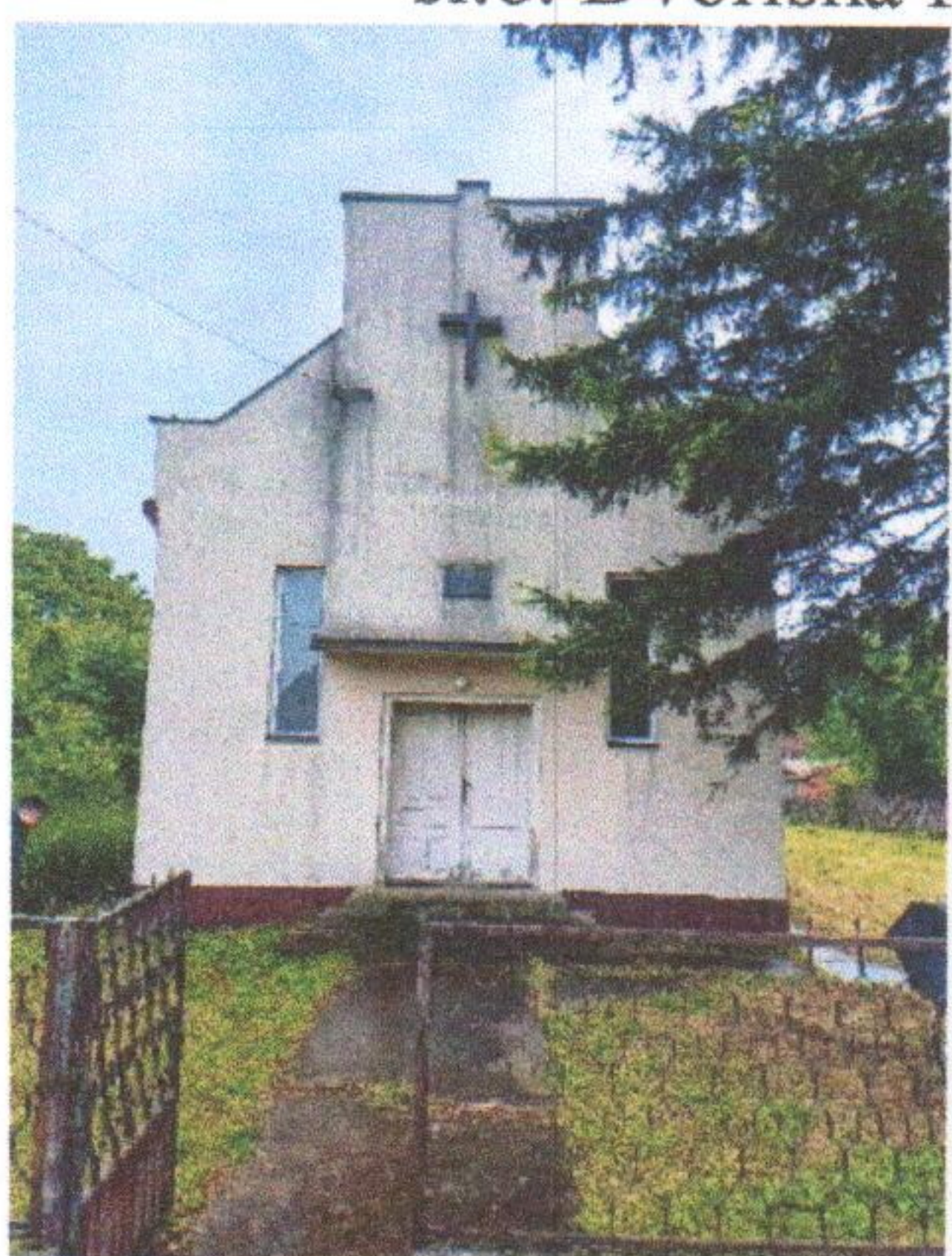
Sl.10. Ulaz u objekat
